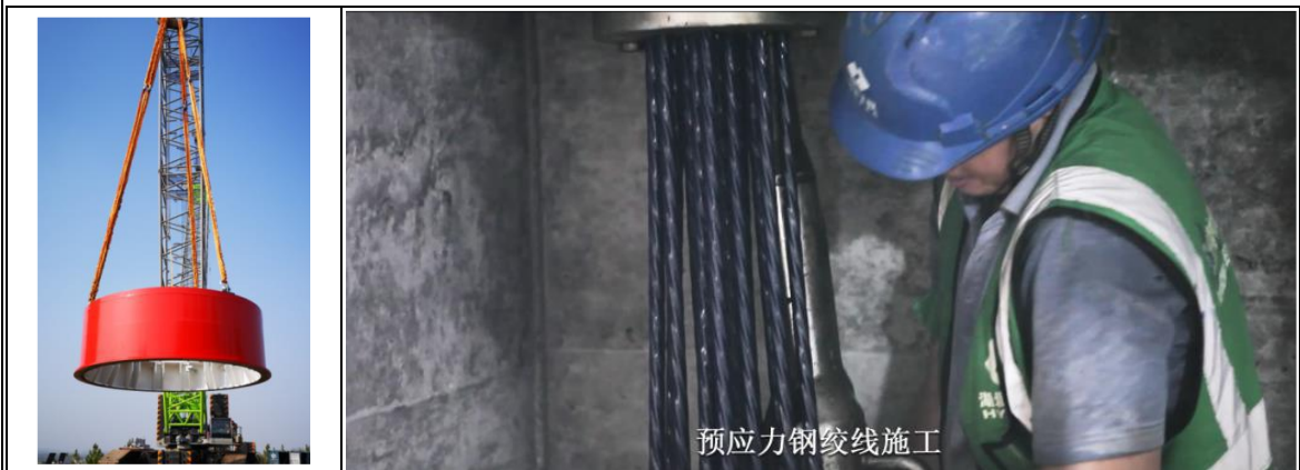
图 2-5 过渡段吊装及预应力施工示意图
