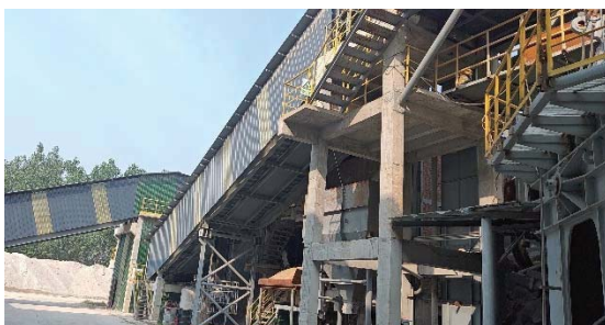
项目输送皮带（已封闭）
