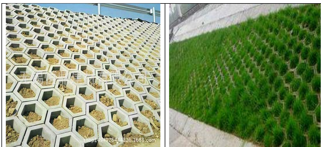
图 2-6 植草砖生态护岸建成后实景图
